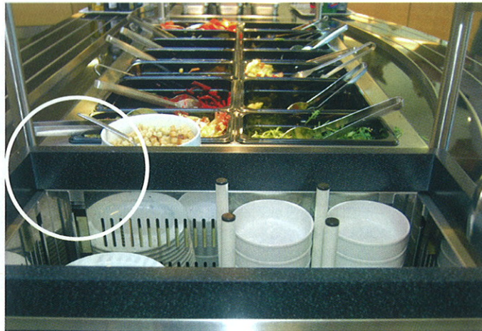
In die Erhöhung um den Tellerstapler sind Antennenplätze integriert, die dem Geschirr über die hinterlegte Datenbank die Codierung Salat zuordnen.
